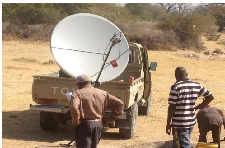
Fig.13. Instalação da antena VSAT na Oficina do Manquete
